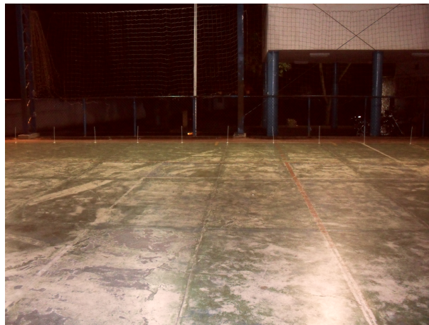
Figura 3.2 - A pista construída na quadra do colégio
