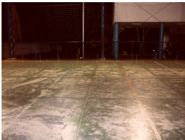
Figura A.2 - A pista construída na quadra do colégio
