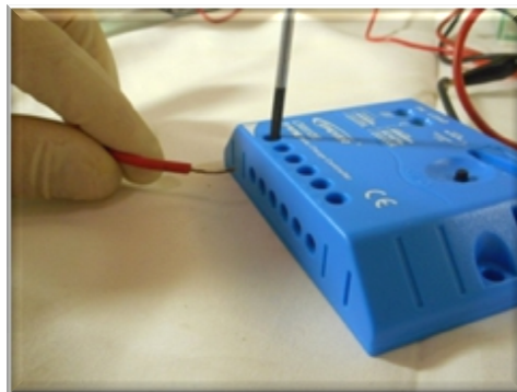
Figura 35 - Conexão do cabo positivo do painel fotovoltaico no controlador
