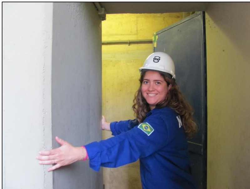
Figura 45-Elementos de proteção radiológica: parede de concreto e porta de chumbo.
