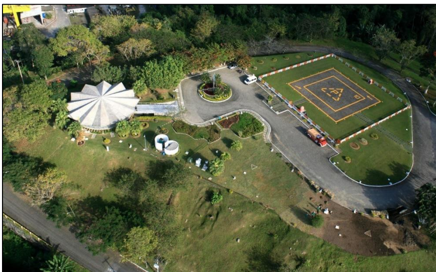
Figura 47-Vista aérea do Centro de Informação de Itaorna.
